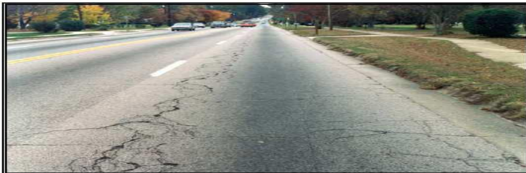
Figura IX.5. Plasaritje e mesme e asfaltit në formë aligatori
