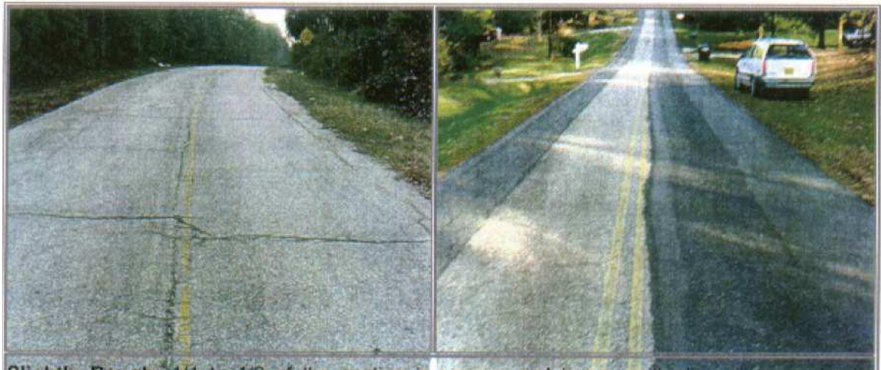
Figura IX.17. Cilësia e mesme e ngasjes si tregues i cilësisë së rrugës
