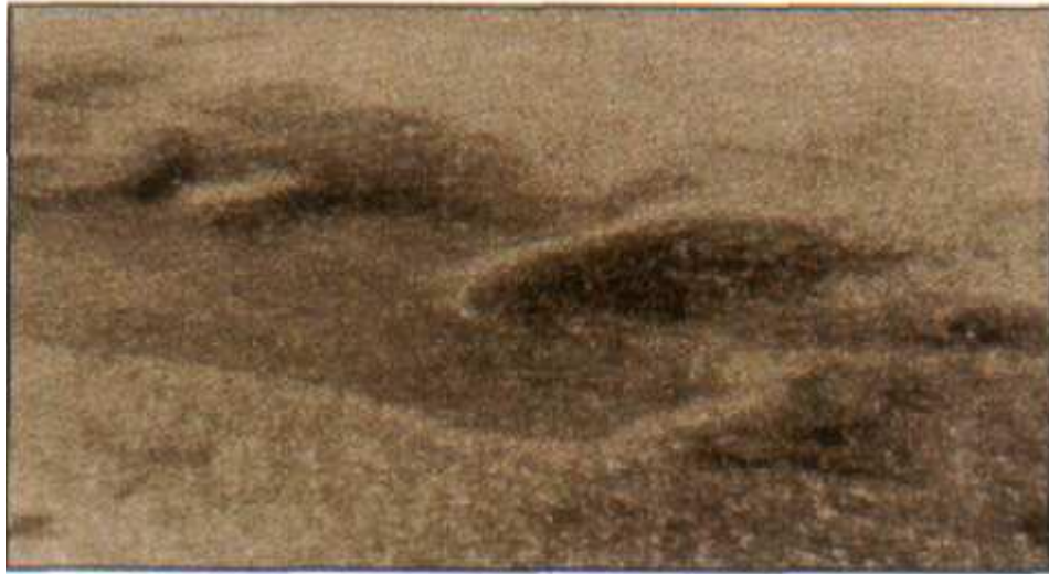
Figura IX.25.Valëzimi në sipërfaqen e shtresës së asfaltit
