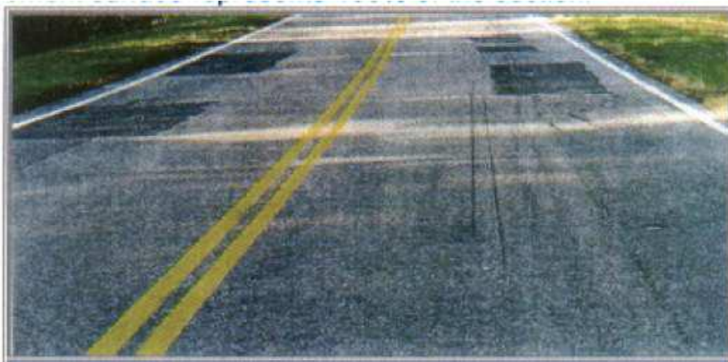
Figura IX.19. Arnimi i sipërfaqes së rrugës
