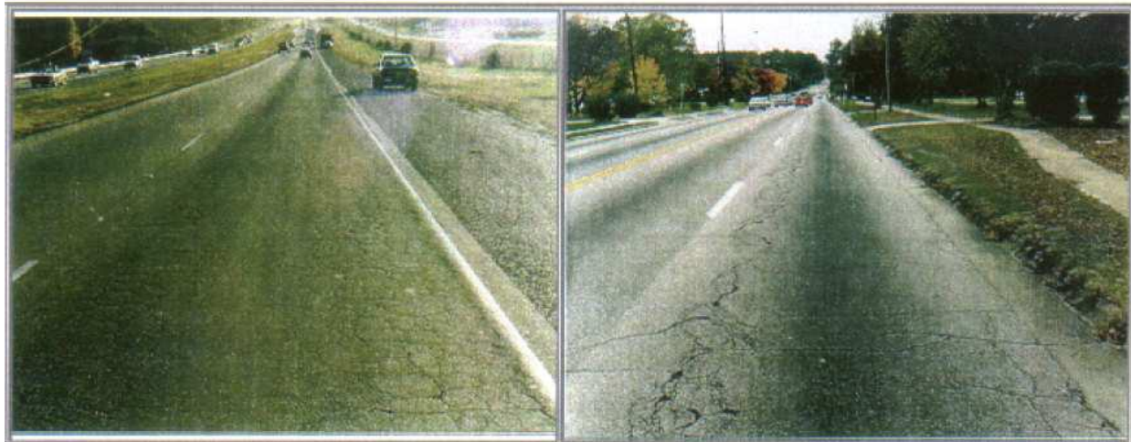
Figura IX.18. Cilësia pak e ashpër e ngasjes si tregues i cilësisë së rrugës
