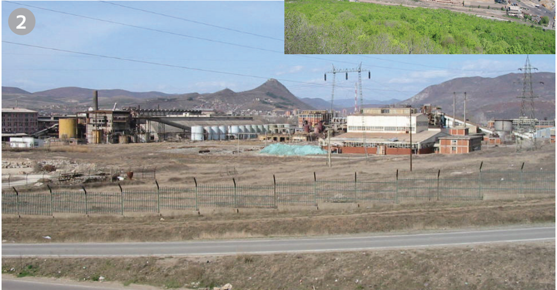
Figura 10. Metalurgjia e plumbit Trepça në Zveçan (1) dhe zinkut në Mitrovicë (2)
